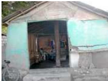
État du corps principal du bâtiment
